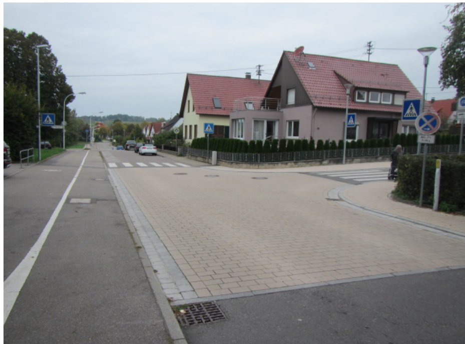
Abb. 7-11: Pflasterung eines Knotens in Rutesheim
