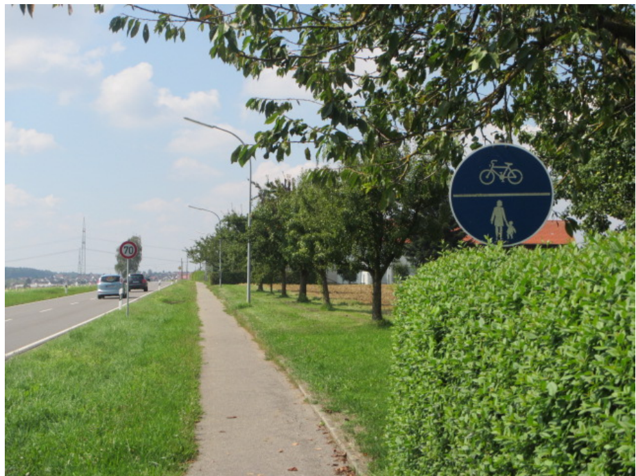
Abb. 7-18: Rad- / Gehweg zwischen Sindlingen und Jettingen
