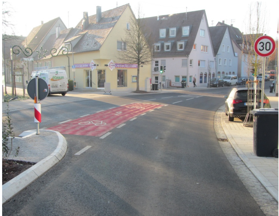
Abb. 7-10: Querungshilfe mit nachgelagerter Aufstellfläche für linksabbiegenden Radverkehr
